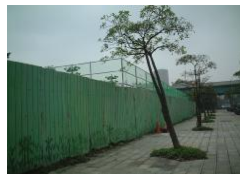
照片三 地震中心旁之施工圍籬區
