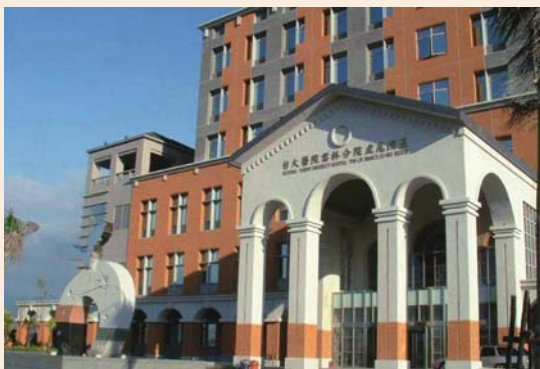
雲林分部臺大醫院虎尾院區第一期醫療大樓
