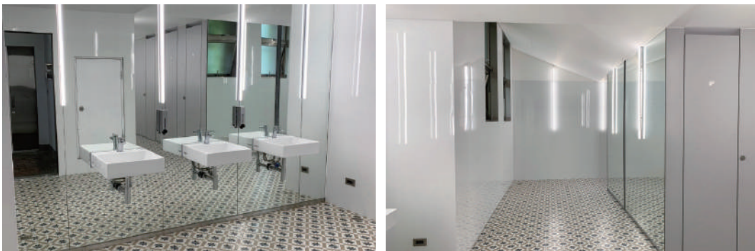
工綜館 1 樓中區性別友善廁所
