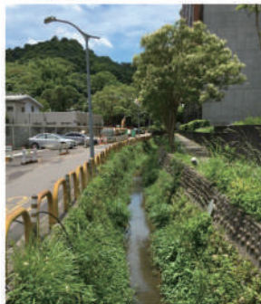
原有水溝整理
