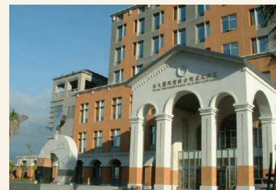
雲林分部臺大醫院虎尾院區第一期醫療大樓
