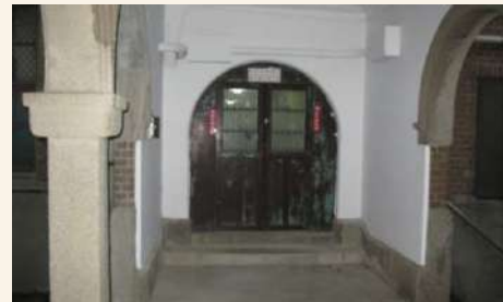
穿廊中間的既有木門扇需粉刷整理
