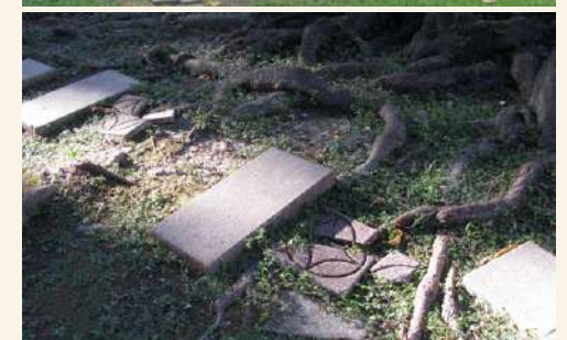
北側中庭現況步道破碎、低窪處積水
