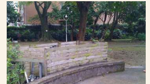
水池機電設備之木格柵現況
