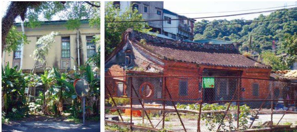
▲ 昆蟲館歷史性建築物的保存與永續使用 ▲ 芳蘭大厝的活化與再利用
