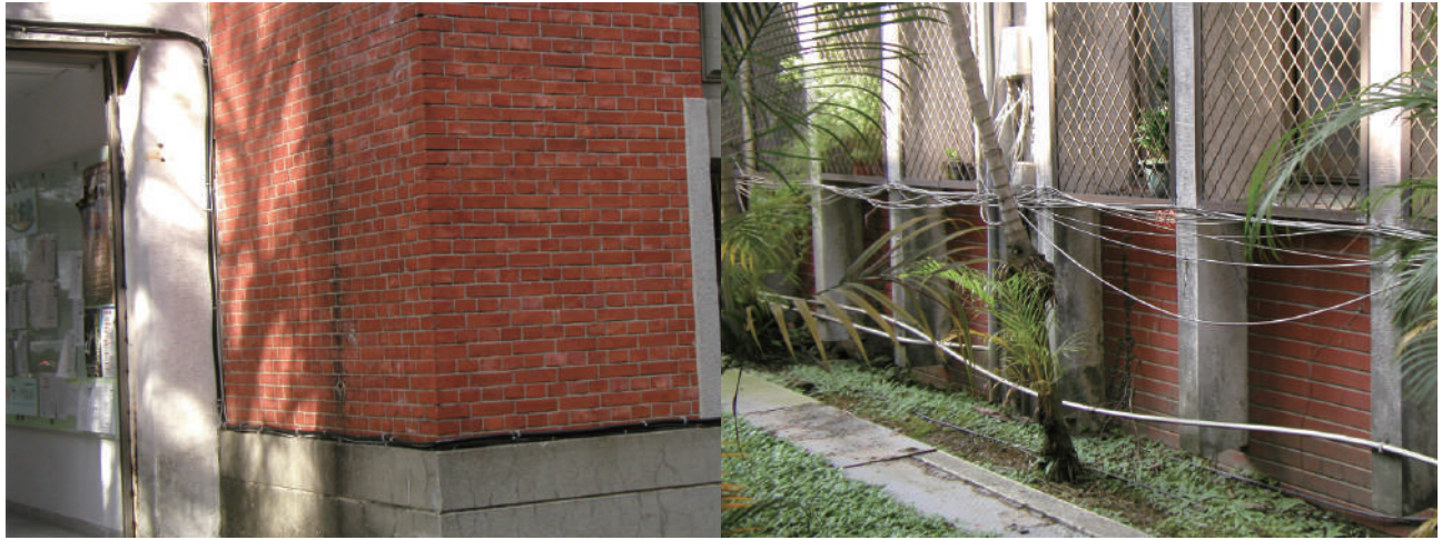
沿轉角處妥善固定
