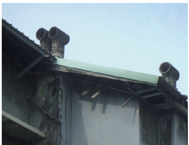
機械館屋頂的舊式煙囪
