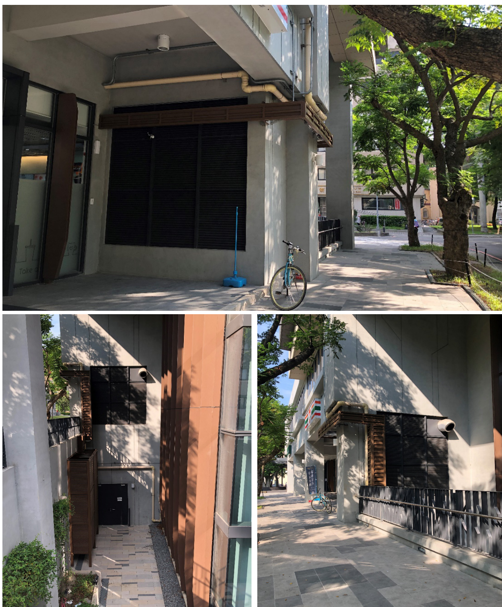
禮賢樓空調室外機及管道美化改善完成現況照片
