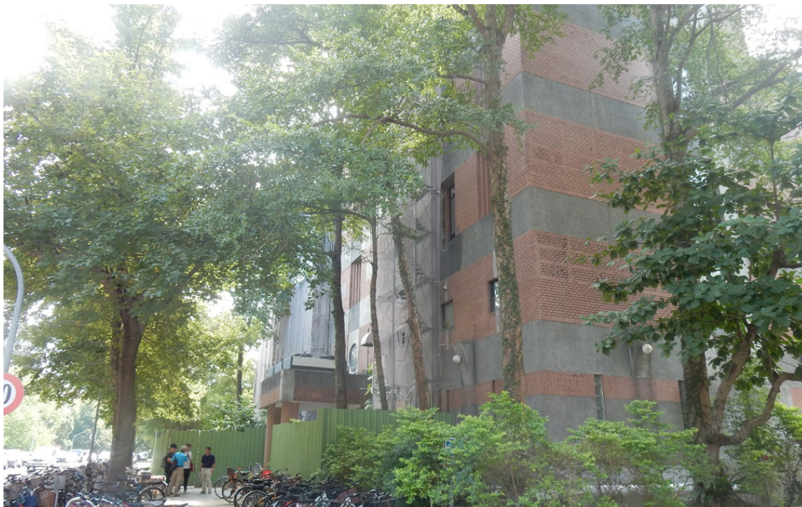
資訊工程館施工狀況
