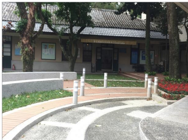
望樂樓中庭完工照片
