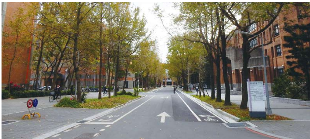
楓香道完工後照片，取消路邊汽車停車格，劃設腳踏車專用道。
