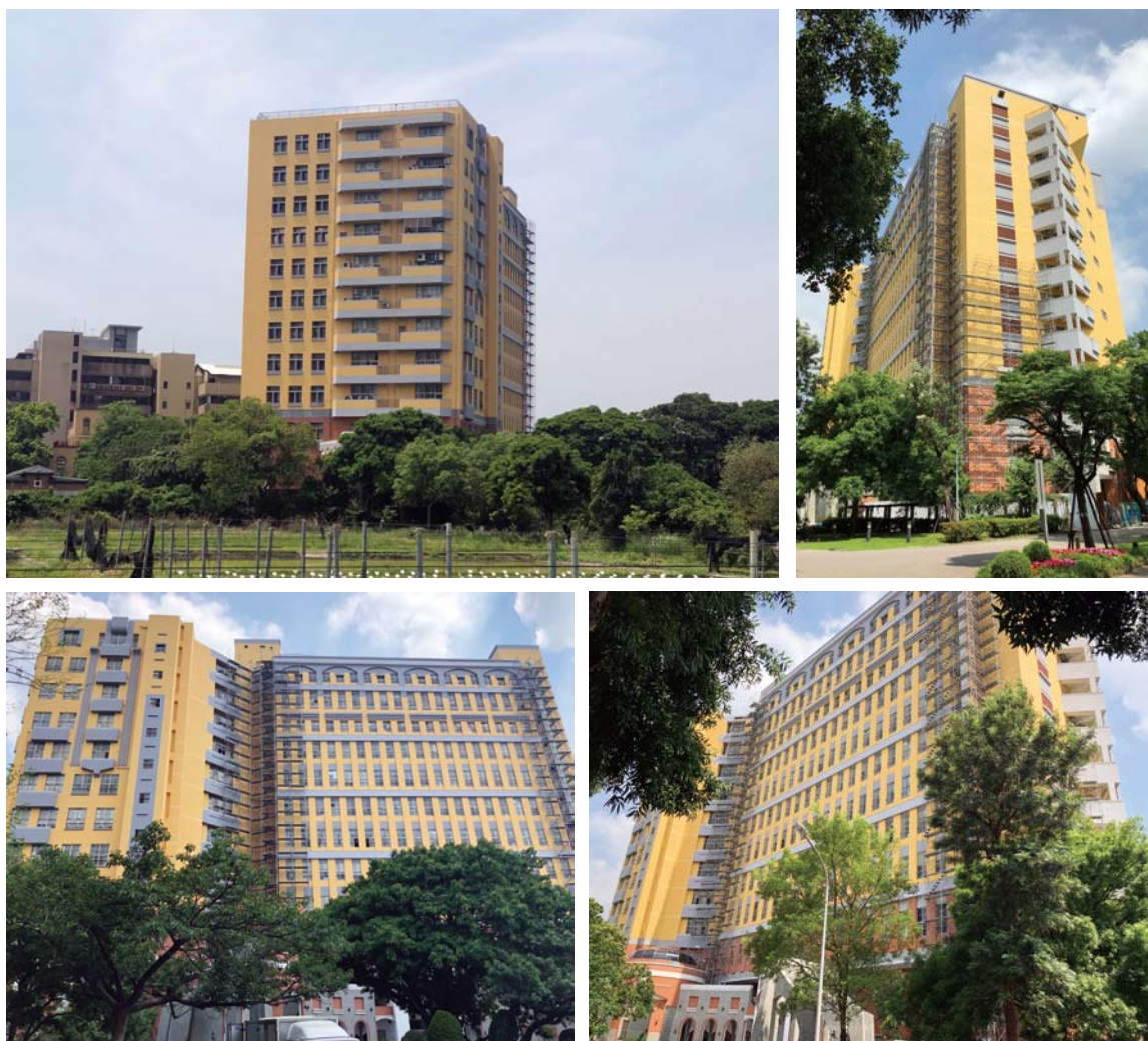
生命科學館大樓施工過程
