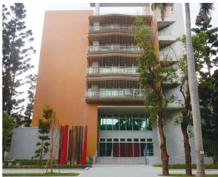
設置完成現況
