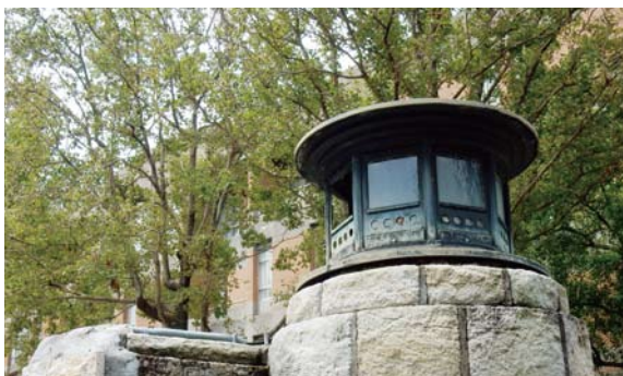
門柱燈片破損，依原式樣予以修補
