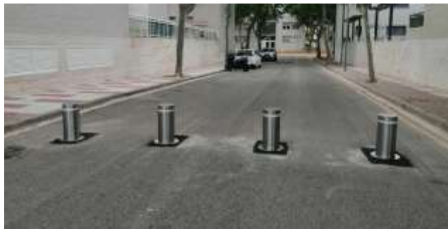
圖 8-5、升降式車阻示意圖
