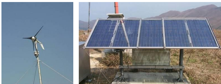
小型風力發電機配合太陽能光電板構成風光互補混合直留供電系統，為自動氣象站提供電力。(香港天文臺自動氣象站)
