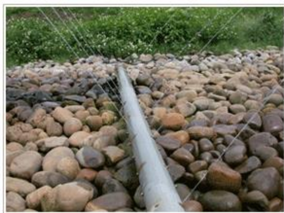
礫間排污處理以濾水管噴水
