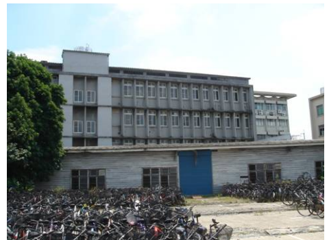
圖 2-3 荒廢閒置的老舊建築
