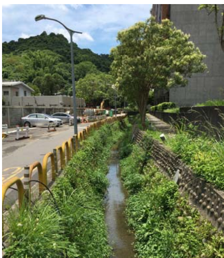
原有水溝整理
